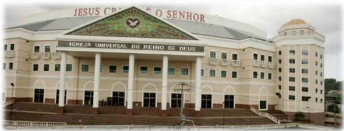
Edificio de la Iglesia Universal del Reino de Dios, Salvador de Bahía
