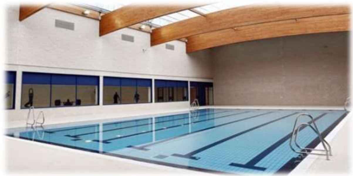
Centro penitenciario de Archidona (Málaga)
