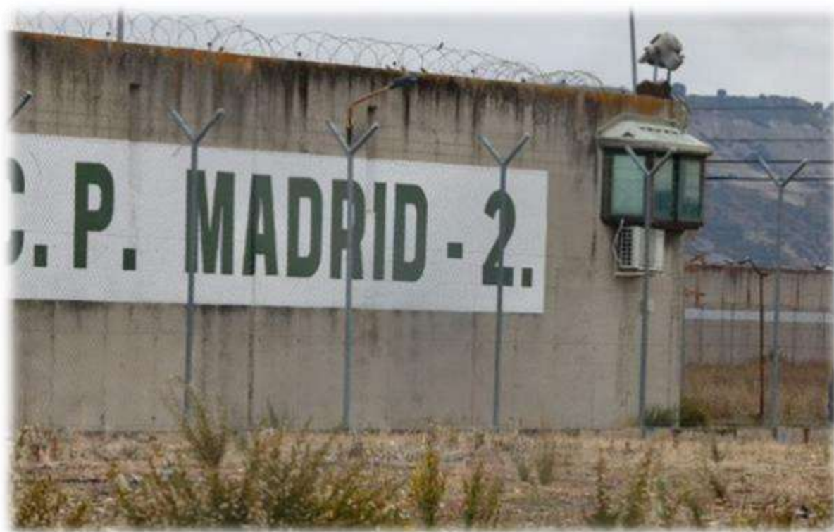
Exterior del centro penitenciario de Alcalá-Meco, a 8 de noviembre de 2022, en Alcalá de Henares, Madrid (España).
